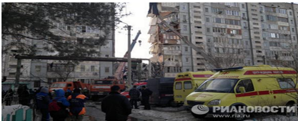
Зураг 4. Хоёр дугаар давхрын дэлбэрэлтээс бүхэл бүтэн нэг орц нурсан байдал.
